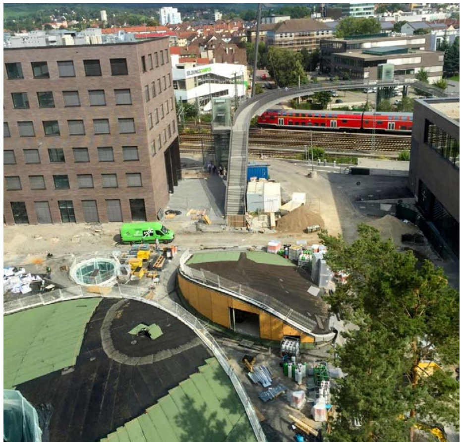
Bildung und Innovation von oben gesehen: Blick aus den Räumen der Campus Founders auf die neue und bald begrünte Mensa.
